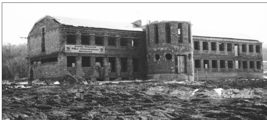
Nová budova Krásnobrodského monastyra počas budovania v decembri 1998 a februári 1999. Ľavá časť monastyra (pod kuchyňou a jedálňou) je podpivničená.
