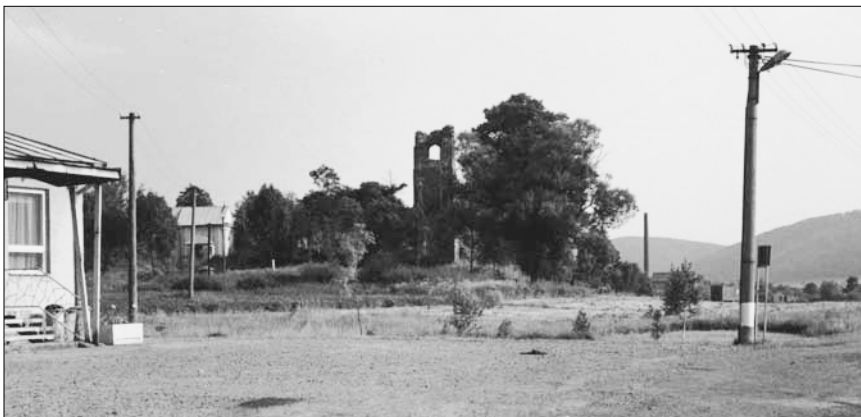
Rozvaliny Krásnobrodského monastyra a kaplnka Pokrova Presvj. Bohorodici v pohľade od predajne Jednota (vľavo), ktorú baziliáni odkúpili v r. 1996 a táto sa stala základom znovuobnoveného Monastyra. Fotografia z r. 1991.
