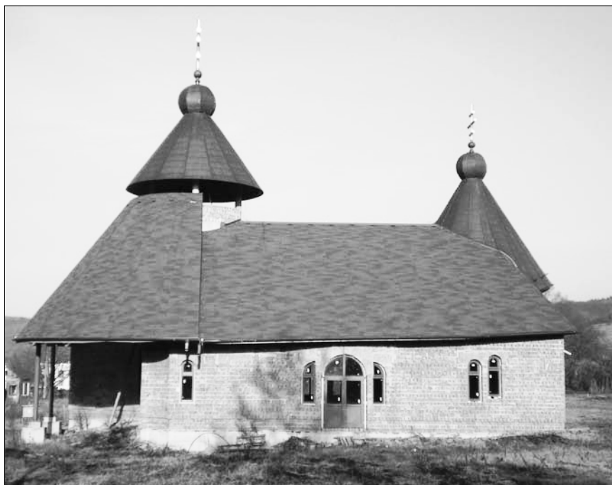
Budovanie novej cirkvi Sv. Ducha v Krásnobrodskom monastýre v r. 2005 (obr. hore) a 2006 (dole). Steny sú z pálenej tehly. V pozadí vľavo je vidno rozvaliny starej cirkvi Zoslania (Sošestvíja) Sv. Ducha z r. 1752... Spodná fotografia je z archíva Ing. Slavomíra Čerevku z Krásneho Brodu.
